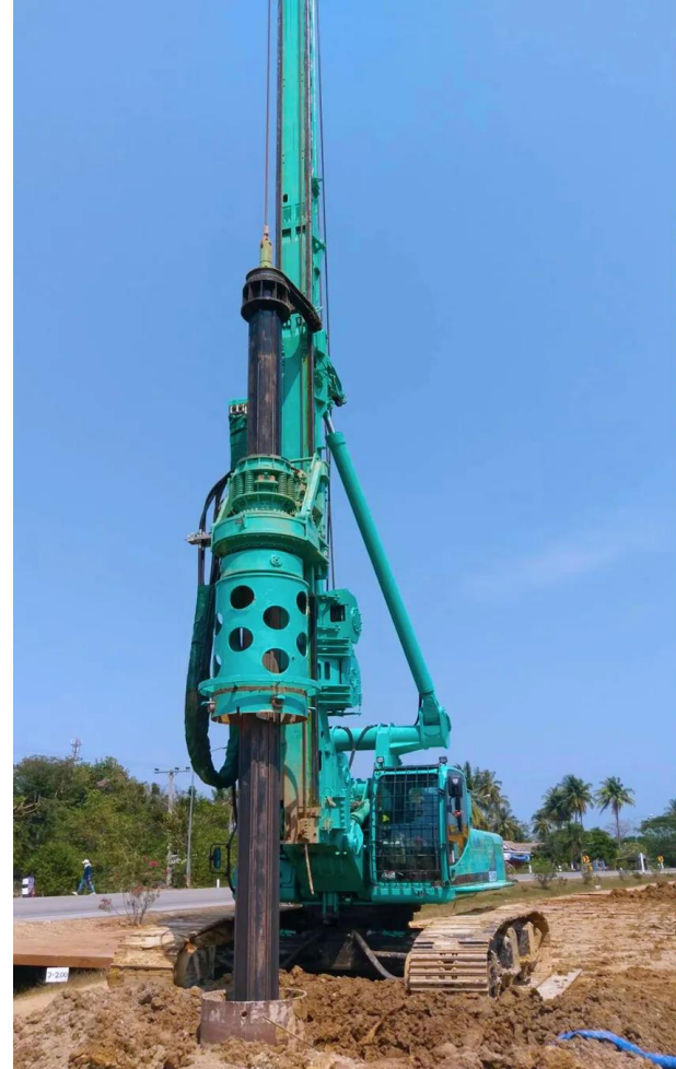
เสาเข็มแบบเจาะ
