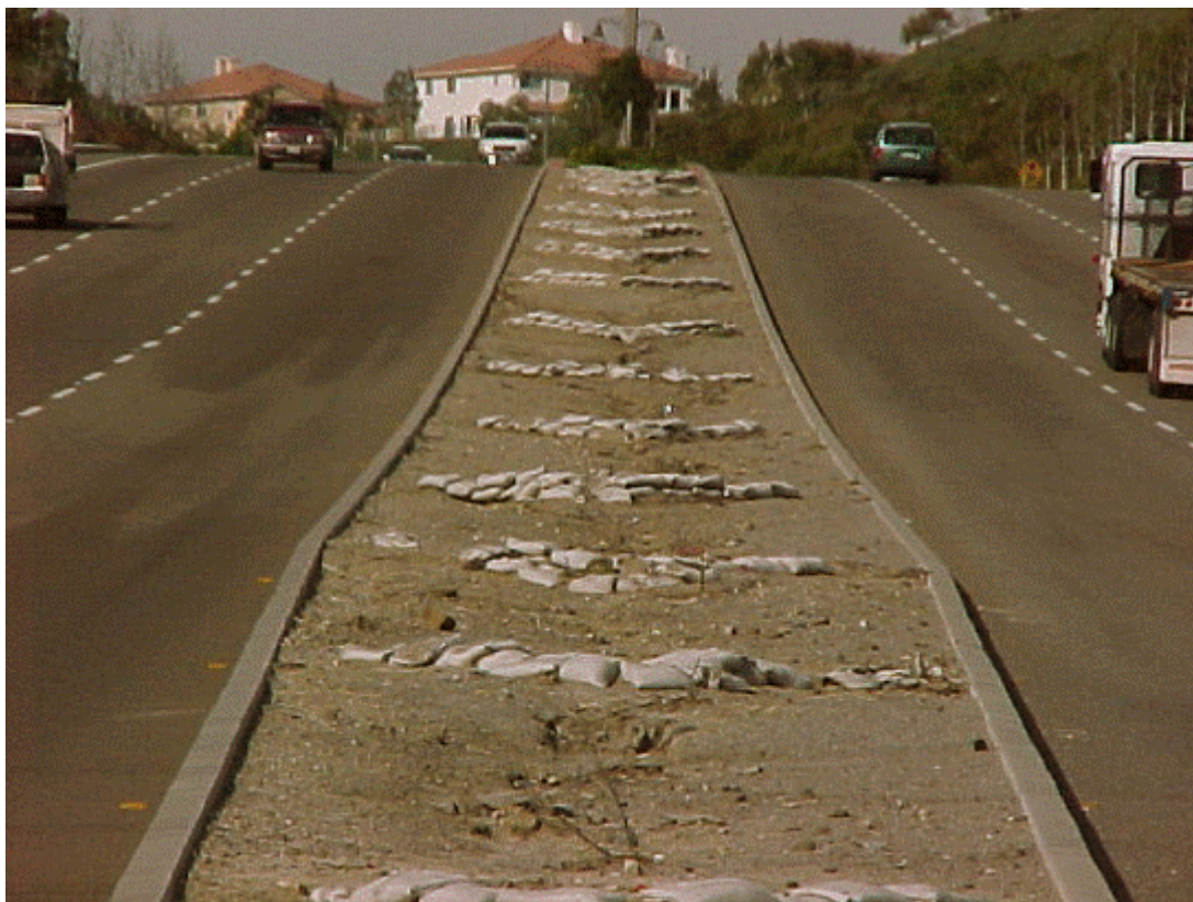
กระสอบทรายถูกวางบนถนนเพื่อควบคุมการกัดเซาะของเกาะกลางถนน
